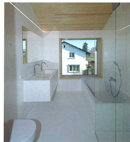
Bad: Boden und Wände des Badezimmers sind fugenfrei mit Epoxidharz beschichtet.
