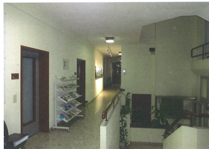
Vor dem Umbau im Erdgeschoss.
